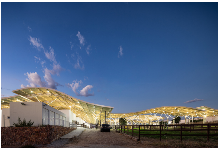
FIGURAS 4 e 5: Imagens Externas. Hospital Veterinário Escola da Unileão. Foto: Joana França. Fonte: Lins Arquitetos Associados, 2023.
