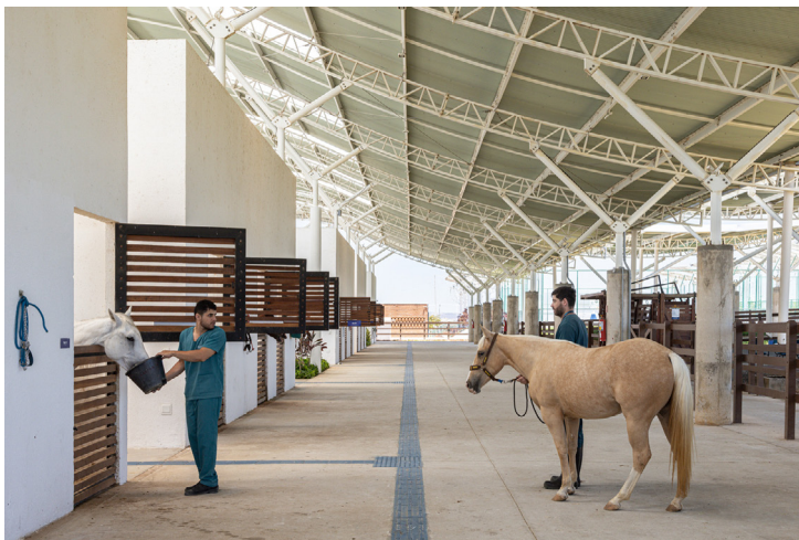
FIGURAS 6 e 7: Espaços Internos. Hospital Veterinário Escola da Unileão. Foto: Joana França. Fonte: Lins Arquitetos Associados, 2023.
